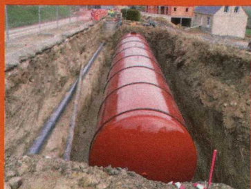
4 futures maisons dans le lotissement "Le Vivier"
